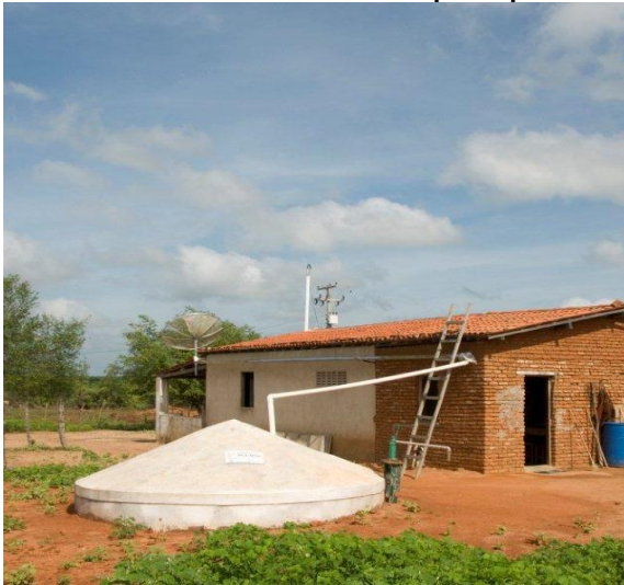
Cisterna de placas de 16 mil litros
