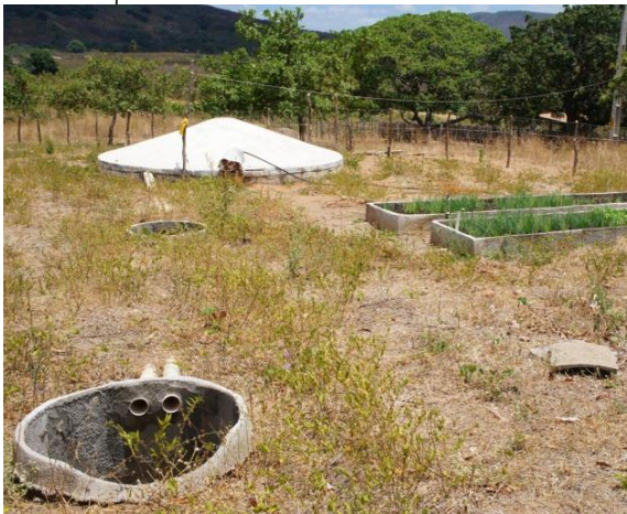
Cisterna de enxurradas de 52 mil litros
