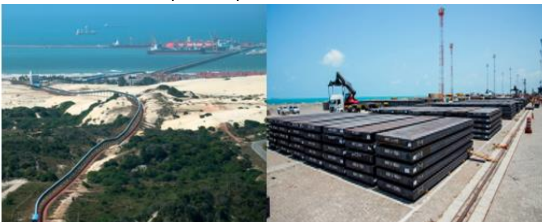
Figura 2 Correia transportadora enclausurada responsável pelo transporte das principais matérias-primas do Porto para CSP e placas da CSP no Porto do Pecém.
