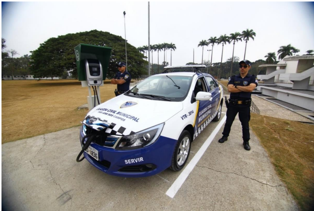
Figura 3 Ponto de recarga localizado no Paço Municipal de São José dos Campos
